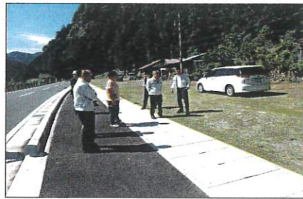
国道169号拡幅工事後の民有地
