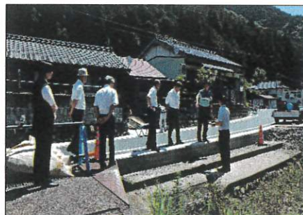
村道木屋西久保線改良工事場所
