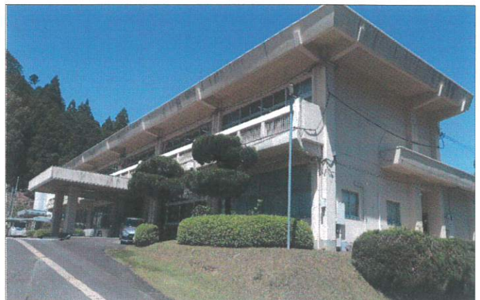
改修工事が予定されている中学校
