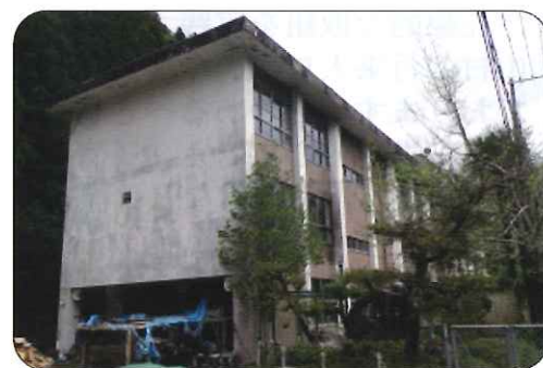
旧小学校等撤去工事
