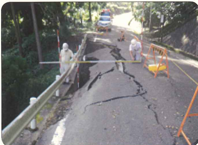
村道上滝下滝線道路災害復旧（小松） （平成27年7月台風第11号被害）L=25m
