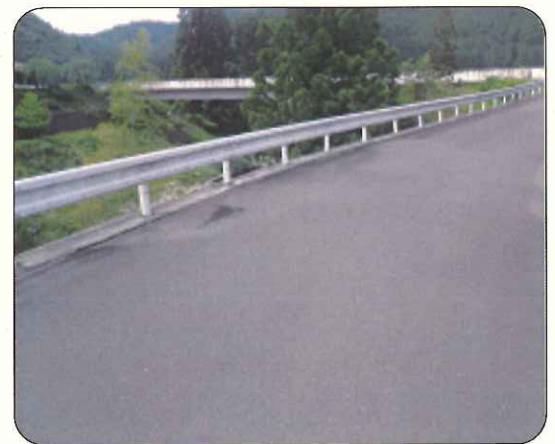
村道中里線舗装箇所
