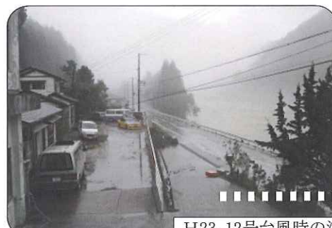
H23. 12号台風時の洪水被害 旧小学校より
