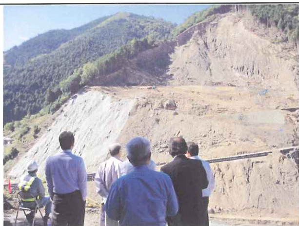
（五条市大塔町宇井の天ノ川沿い斜面の崩壊） 対岸の清水地区の土砂崩れが宇井地区の民家を襲い7人が死亡、4人が行方不明となった箇所。
