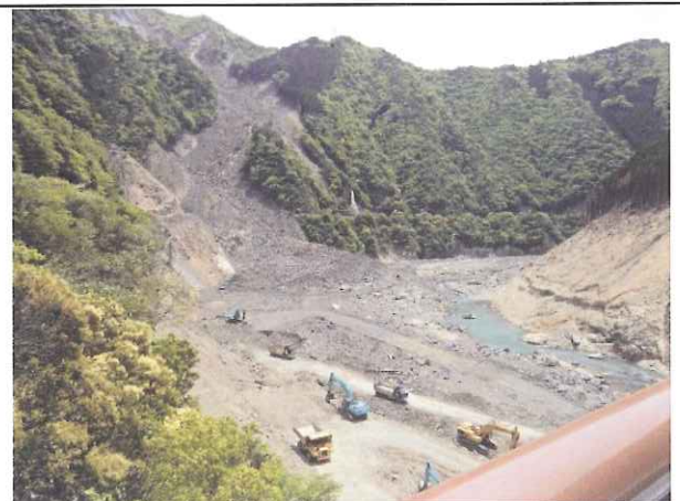
（十津川村 宇宮原地区の崩壊） 土砂崩落は、幅約240m、斜面長約660mであり、深さは30～40mと推測される。
