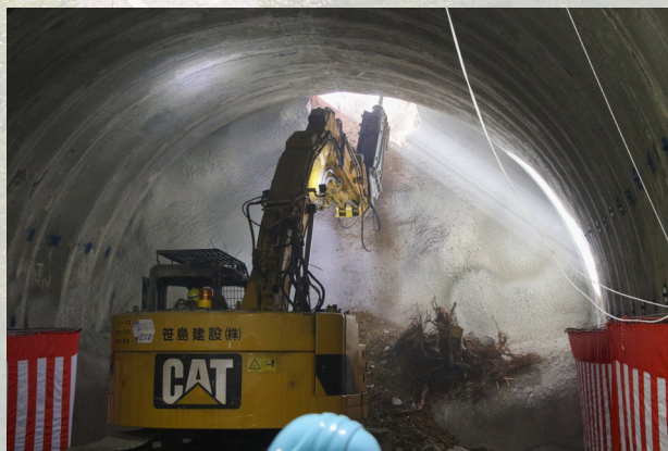
奥瀬道路2号トンネル貫通の瞬間
