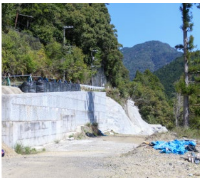
竹原地区の国道2車線化
