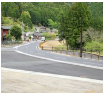
竹原地区の2車線化改良工事
