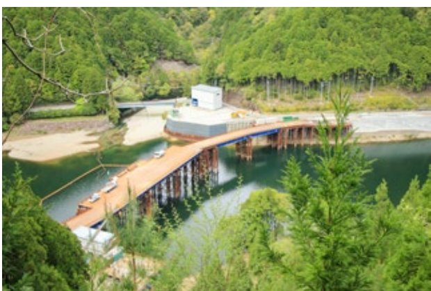
奥瀬Ⅲ期工事
