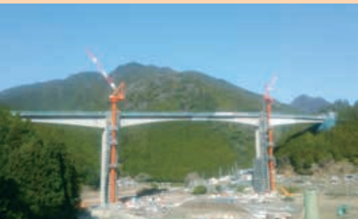
玉置口の工事の様子(3月20日撮影)
