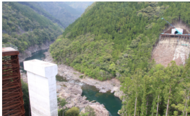
現在の3号橋架橋予定場所の様子
