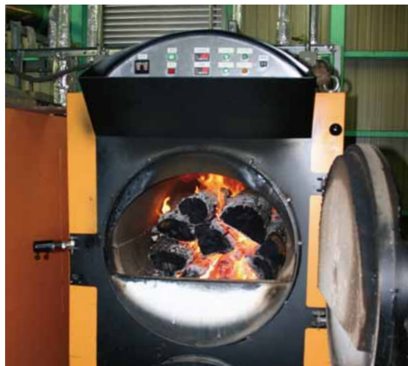
高齢化とともに林業の衰退がすすみ、放置された間伐材の活用と村内エネルギーの自給自足を目的に「バイオマスエネルギー」に取り込んでいます。今後、役場や学校などの公共施設にも取り入れていくことも考えています。
